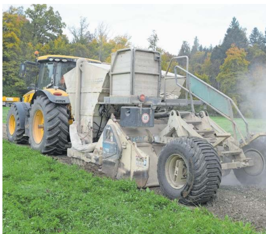
Grosse Maschinen bei den Bauarbeiten am Bergfeldweg.
