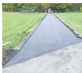
Fertig asphaltierter Weg.
