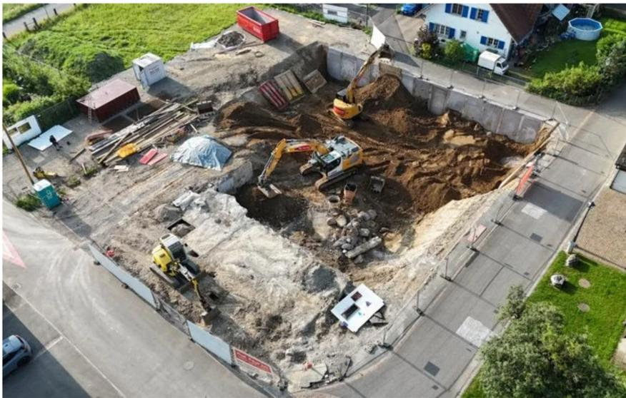
Noch während dn Abbrucharbeiten wurde das Gelände zu den Strassen mit Grubenwänden gesichert.
