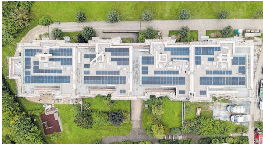
Die neu installierte Photovoltaikanlage mit 152 Panels liefert übers Jahr gerechnet rund 60 000 kWh, die direkt von den Bewohnern bezogen werden.
