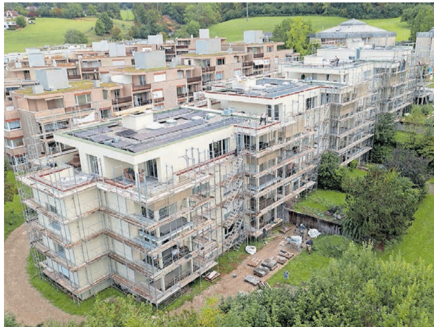
Künftig erstrahlt das Mehrfamilienhaus in einem neuen Farbkonzept.
