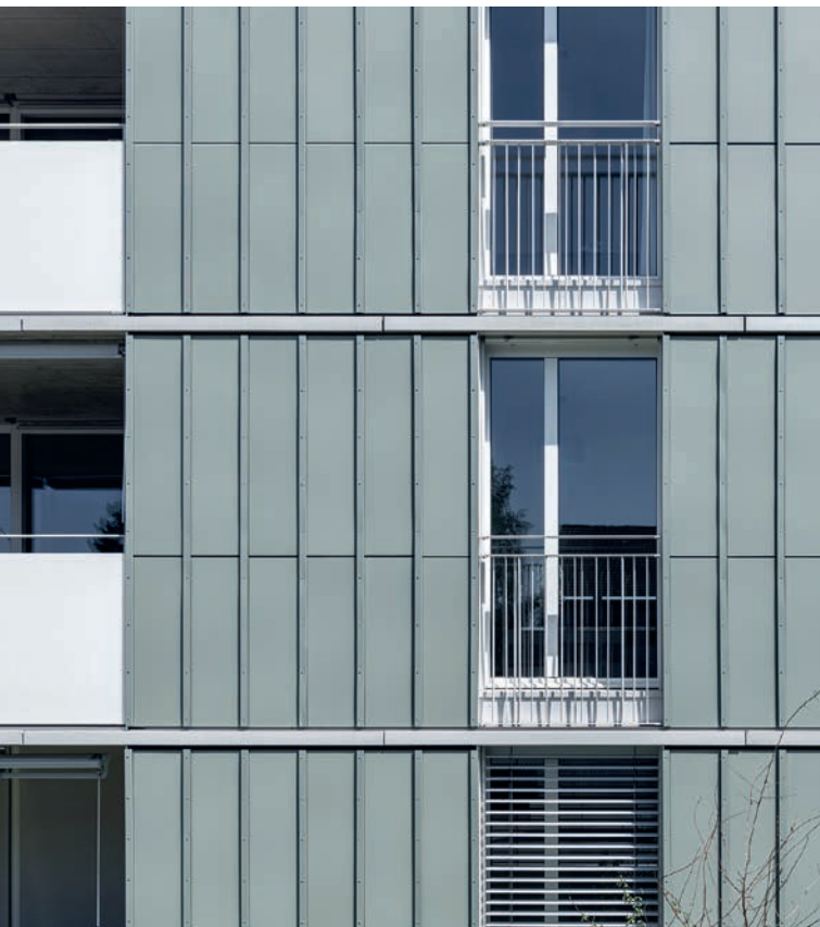
Die Fassade der neuen Siedlung der Umweltarena in Urdorf ist mit Photovoltaikmodulen ausgestattet. (Bild: Umweltarena/Beat Bühler)
