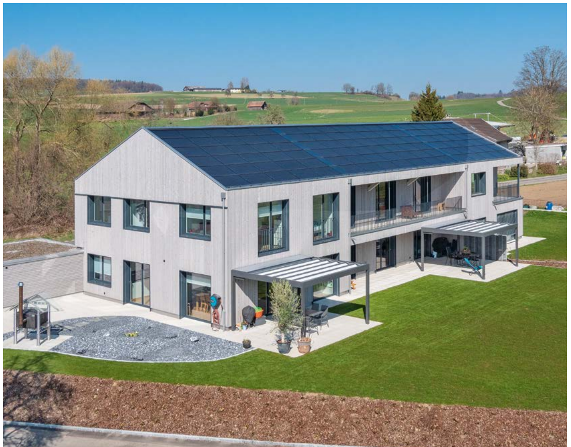
Photovoltaikanlage von BE Netz AG, Ebikon
