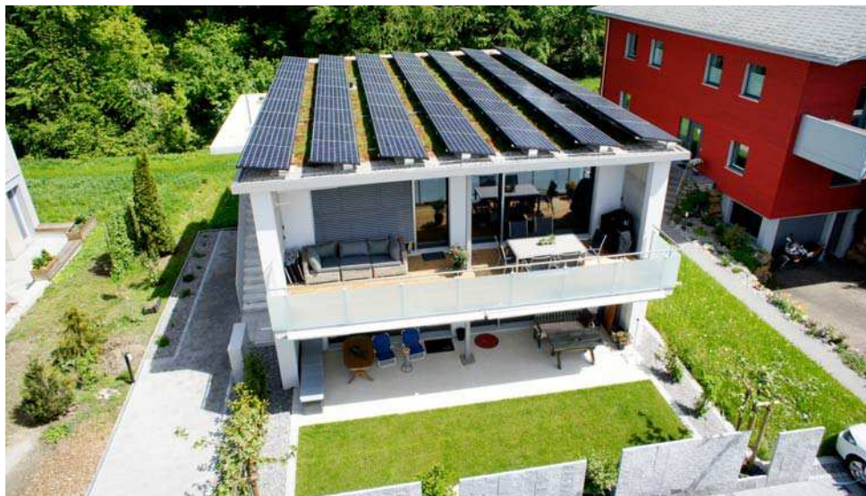
Das «Plusenergiehaus mit Elektromobilität»: Minergie-P-Eco, auf dem Dach die 7 x 9 = 63 PV-Module mit total 20 kWp Leistung, rechts unten der Parkplatz für das Elektroauto. (Fotos: Setz Architektur)
