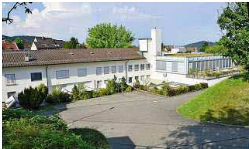
Die nicht mehr benötigte Betriebsliegenschaft der Lerchmüller AG muss dem Neubau weichen
