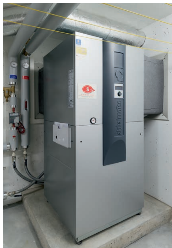
alpha innotec Luft/Wasser-Wärmepumpe LWC 80E mit Luftkanalsystem LKS 700
