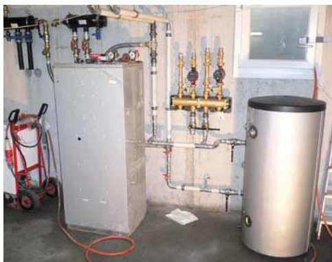
Mit 16.7 kW Heizleistung der Sole-Wasser-Wärmepumpe Alpha-InnoTec SWC 170H von ait Schweiz AG, wird das ganze MFH und das benachbarte EFH beheizt. Links: vorher während der Unterlagsboden-Austrocknungsphase (mit Elektro-Hotboy ganz links) und noch vor Ausführung der Dämmarbeiten. Rechts: nachher, so wie heute in Betrieb. Rechts im Bild: Pufferspeicher 200 Liter zur Wärmepumpe. Nicht im Bild: Warmwasserspeicher mit 1000 Liter Inhalt.
