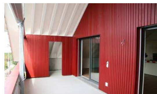
Setz Akzente: die hinterlüftete, bordeauxfarbige Holzfassade.
