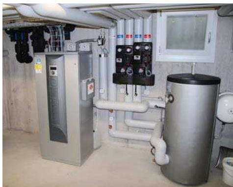
Mit 16.7 kW Heizleistung der Sole-Wasser-Wärmepumpe Alpha-InnoTec SWC 170H von ait Schweiz AG, wird das ganze MFH und das benachbarte EFH beheizt. Links: vorher während der Unterlagsboden-Austrocknungsphase (mit Elektro-Hotboy ganz links) und noch vor Ausführung der Dämmarbeiten. Rechts: nachher, so wie heute in Betrieb. Rechts im Bild: Pufferspeicher 200 Liter zur Wärmepumpe. Nicht im Bild: Warmwasserspeicher mit 1000 Liter Inhalt.
