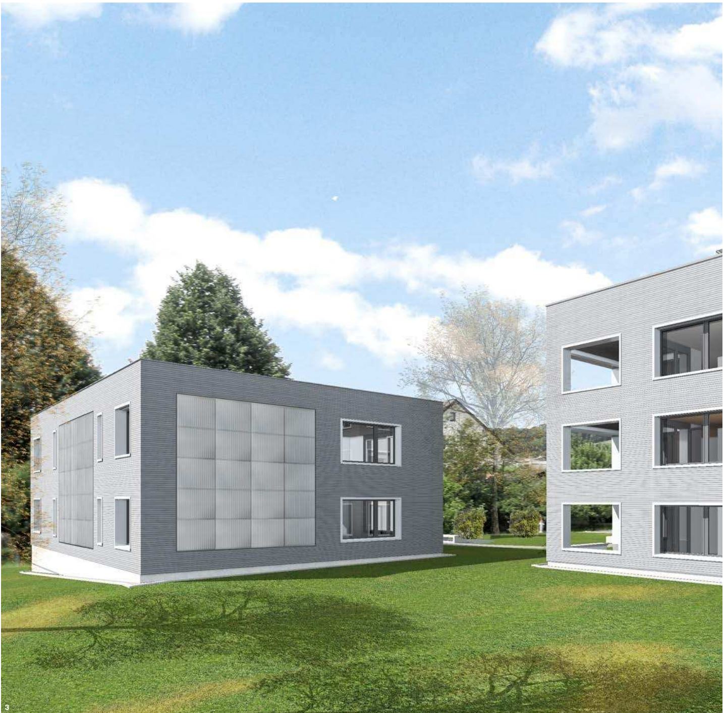
3 PV-Module an Ost- und Südfassaden (im Bild) sowie auf dem Dach des Attikageschosses und auf den Attikaterrassenbrüstungen produzieren in der Jahresbilanz mehr Strom als die Siedlung verbraucht. Der Gesamt-Energieverbrauch des Gebäudes wird über eine Software auf maximalen Eigenverbrauch gesteuert.
